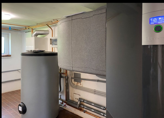
Vnitřní instalace vzduch/voda - LWCV 122
