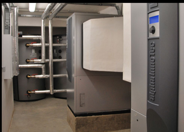
Vnitřní instalace vzduch/voda - 2x LW 251
